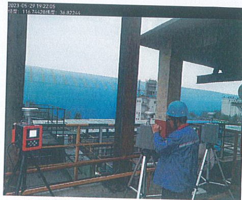
焦炉炉端焦侧的 2/3 处
